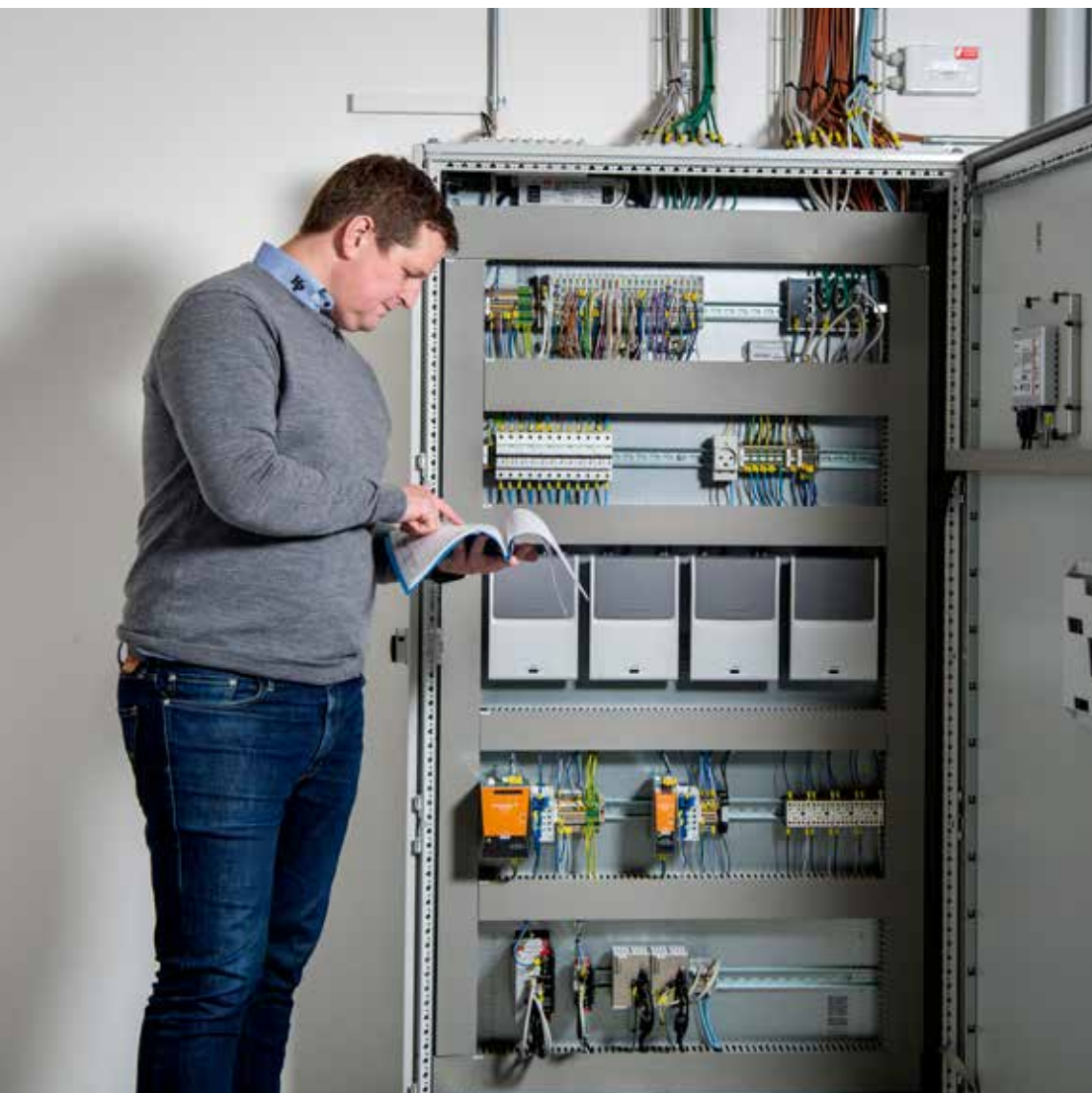
Niels K. Abildgaard foran CTS-tavlen. I nederste venstre hjørne sidder den centrale styrings-PLC.
