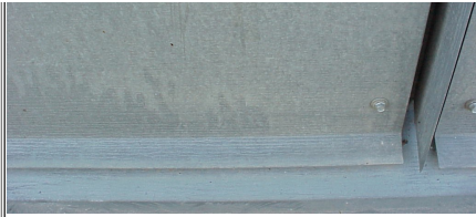
2. Fotoet viser en overflade, hvor forpatineringen er delvist nedbrudt og erstattet af den naturlige patineringslag.
